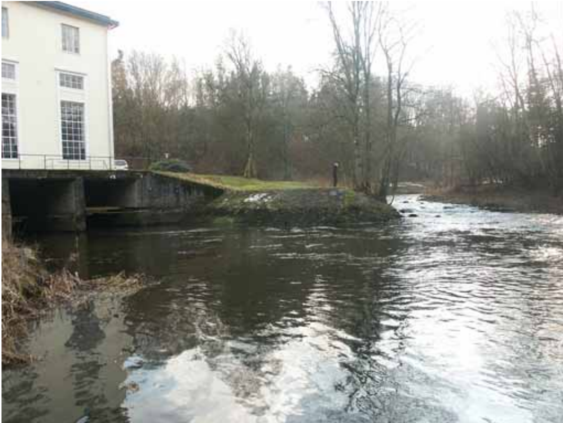
T.v. udløbet fra turbinerne ved Vestbirk Vandkraftværk. T.h. udløbet af Gudenåens oprindelige løb, som får sit vand fra Bredvad Sø, hvor der er et omløb.
